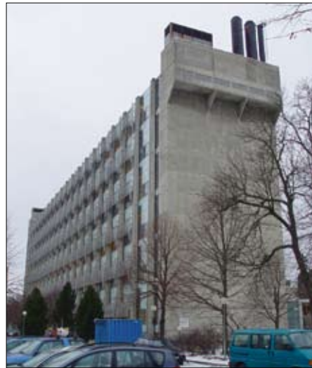
Laboratoriebygget ved Ullevål Universitetssykehus. Foto: Jan Carsten Bjerkfeldt
